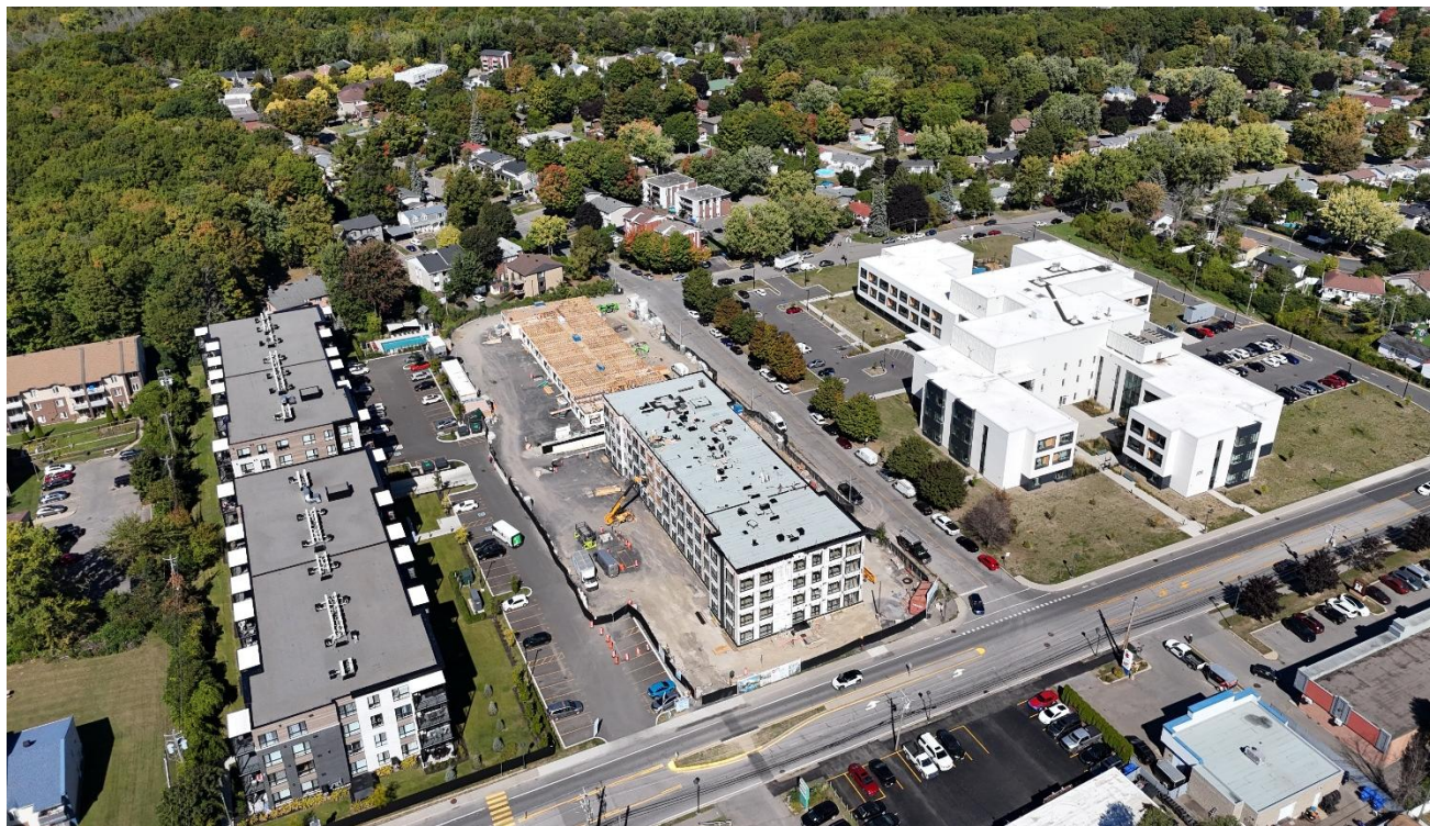
Redéveloppement sur le site d'un ancien concessionnaire et d'un ancien centre commercial, rue Principale à Châteauguay.
